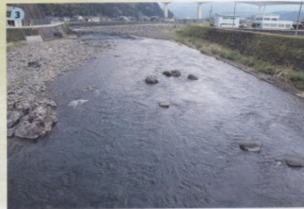
越佐橋上流。橋付近はトロコになっている
